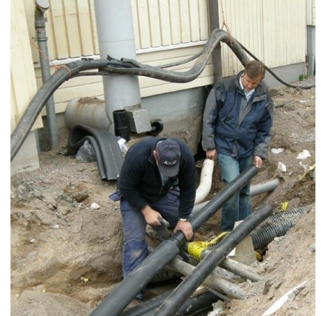
Lämpökanavat asennetaan tarkasti.
